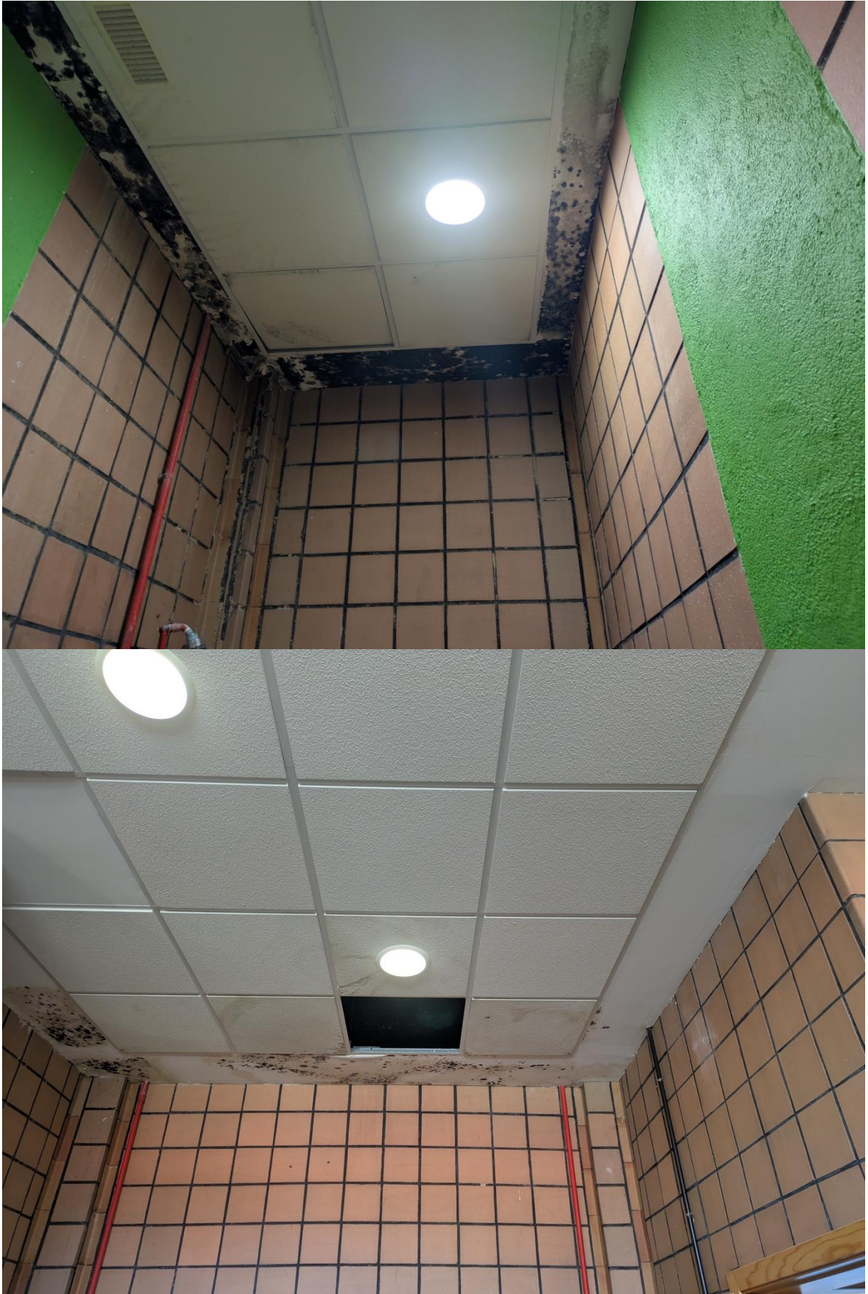
Pt02_ Presencia de moho por humedad en techos.
