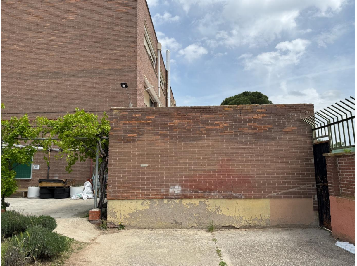
Pt04_ Humedad por falta de sellado en albardillas
