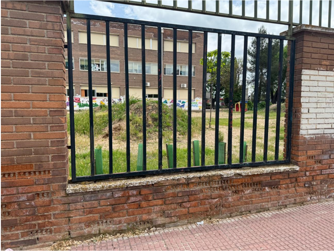
Pt05_ Deterioro revestimiento mortero.
