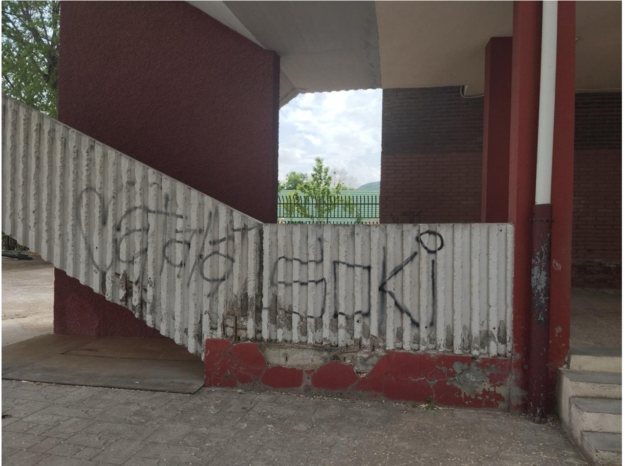
Pt07_ Deterioro acanaladura mortero decorativo escalera exterior.
