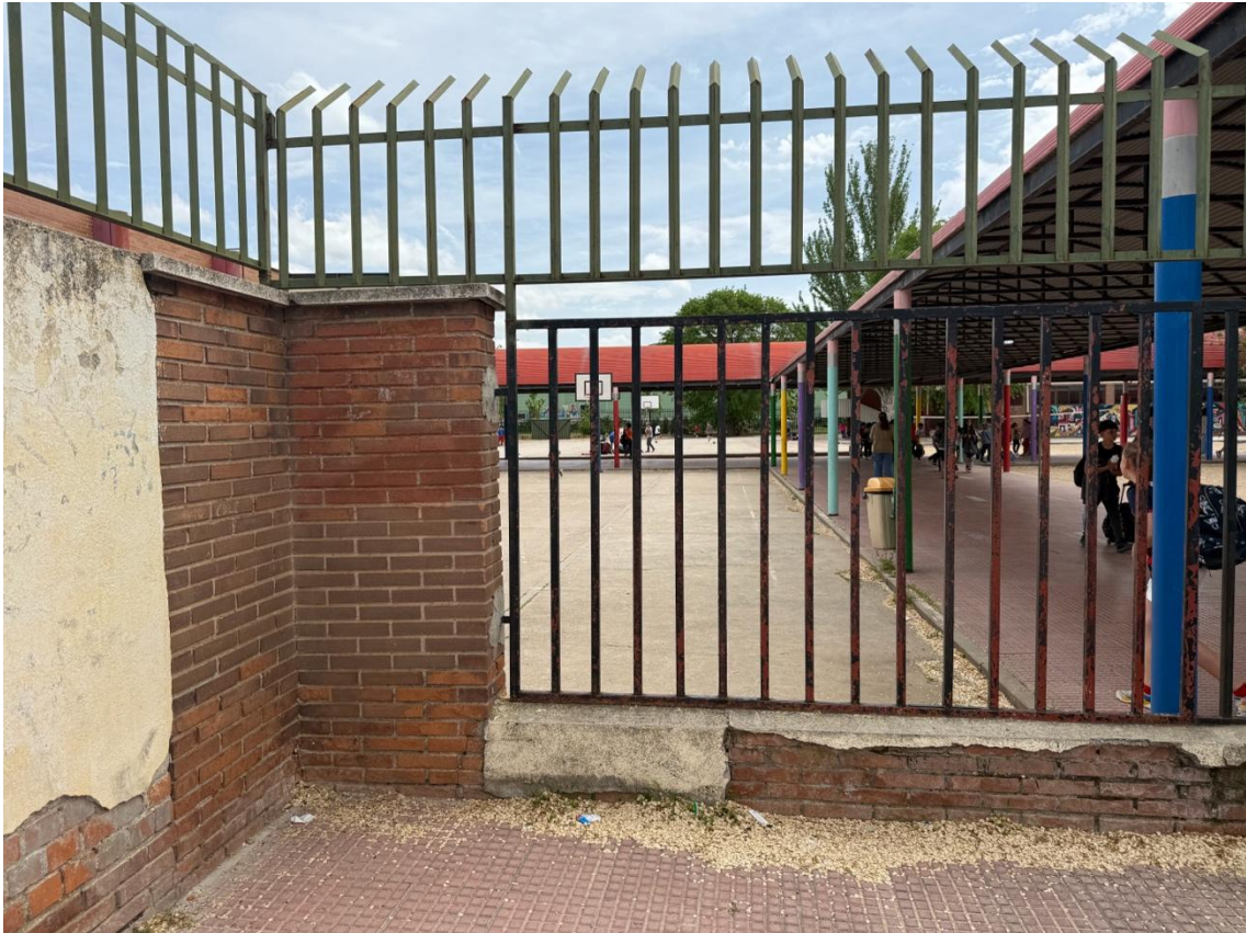
Pt06_ Deterioro de la capa de pintura de la verja metálica con presencia de óxido superficial
