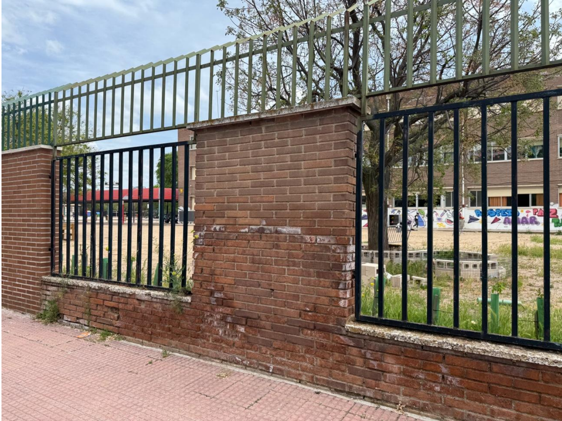
Pt03_ Deterioro de la integridad de los ladrillos.
