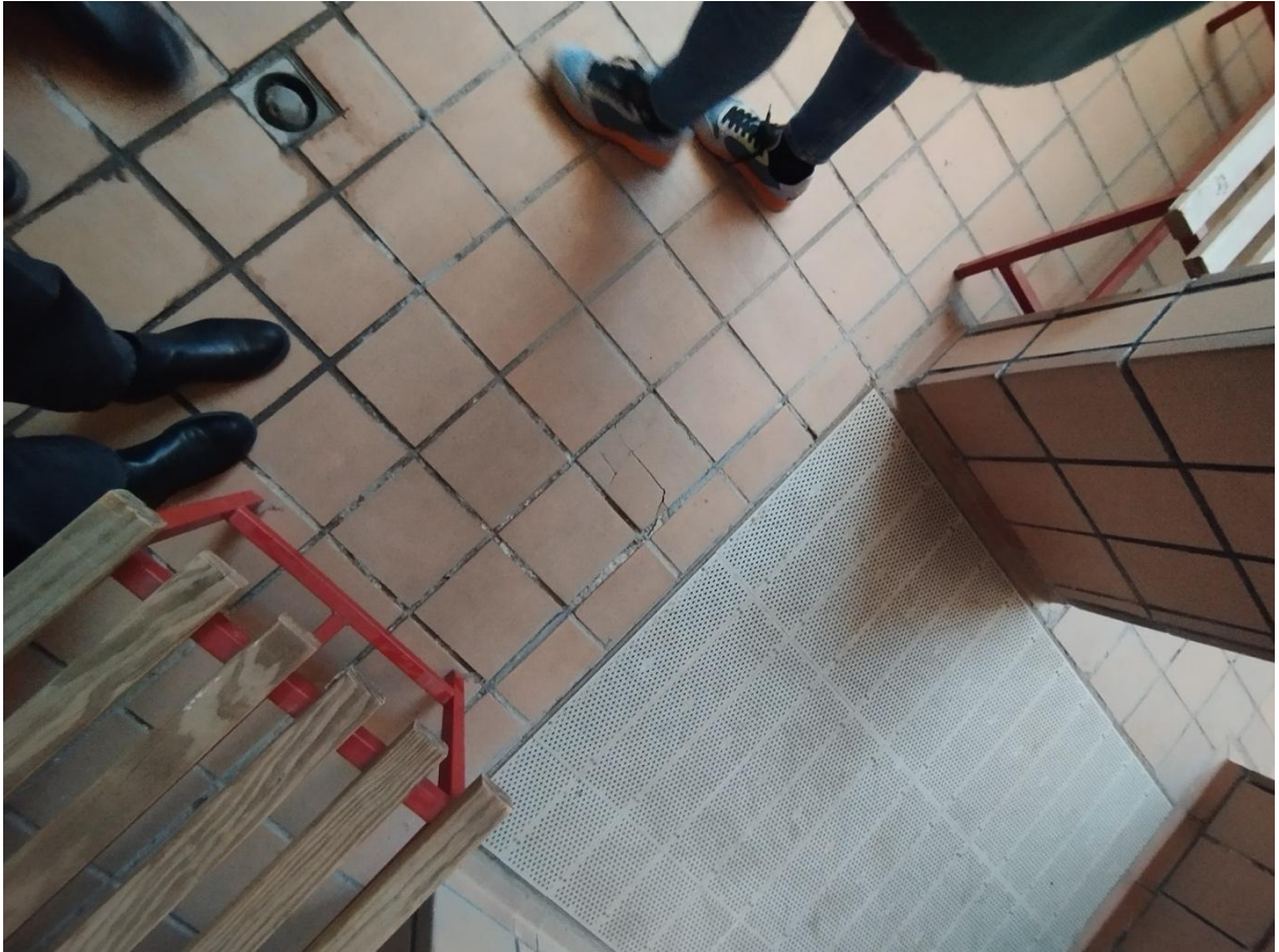
Pt06_ Alteración de adherencia y desprendimiento parcial del pavimento.
