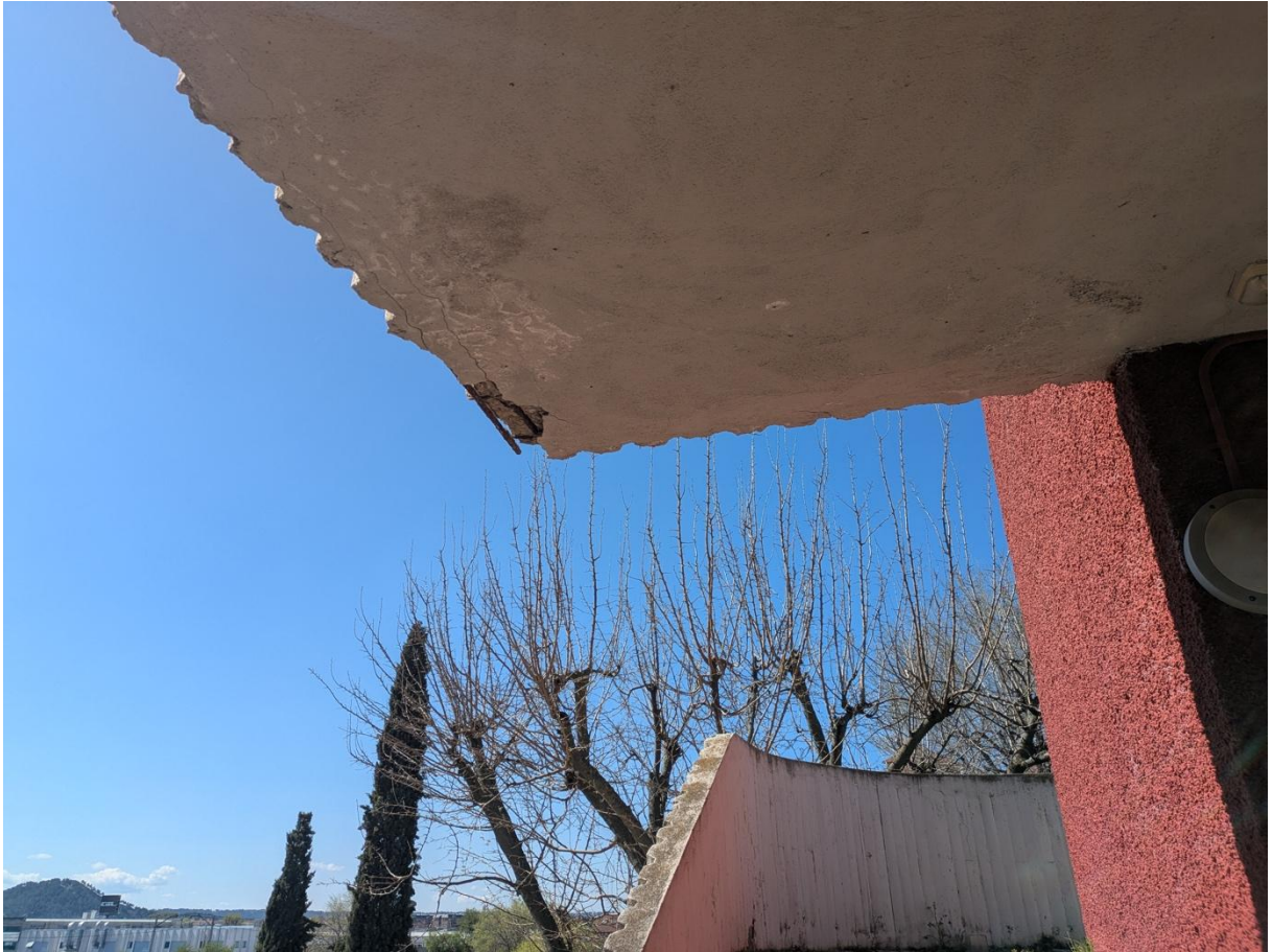
Pt08_ Deterioro recubrimiento redondos acero en escalera exterior.
