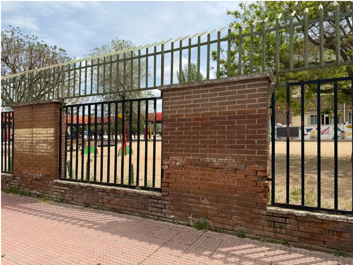
Pt03_ Deterioro de la integridad de los ladrillos.
