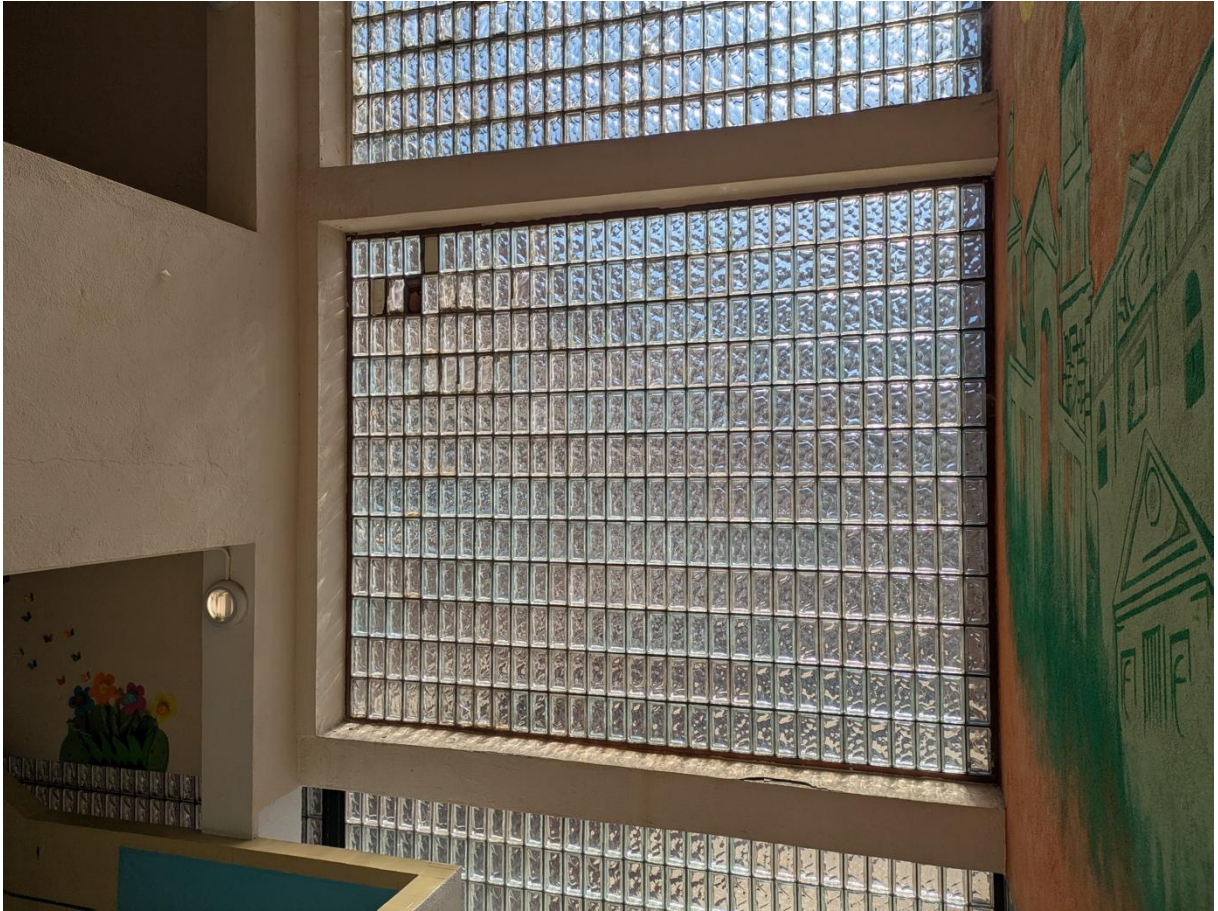
Pt10_ Rotura piezas de pavés por falta de sellado elástico entre piezas.
