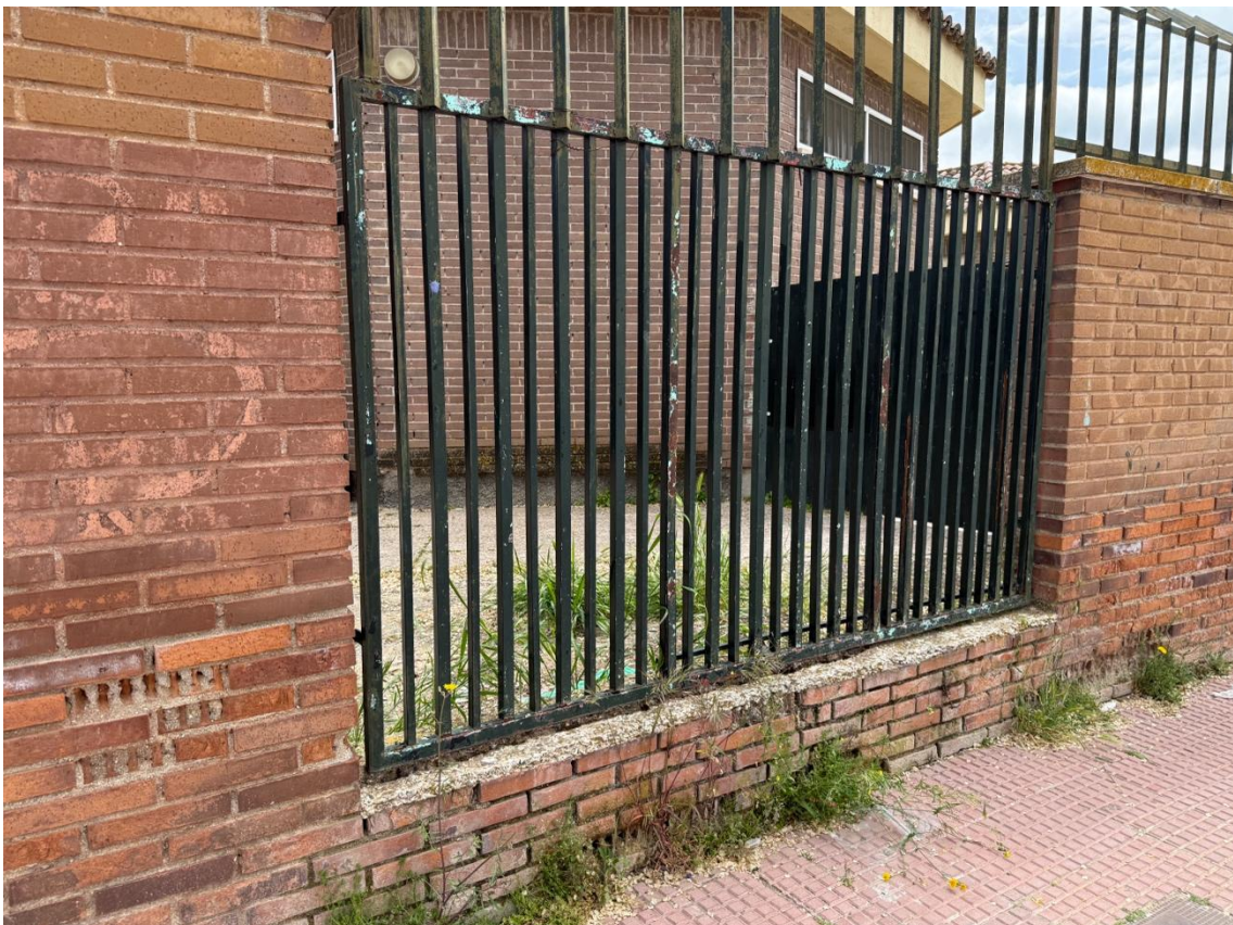
Pt07_ Presencia de óxido en verja metálica con deterioro de la integridad de la misma
